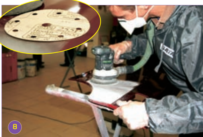
8 Шлифмашинкой с абразивным материалом P500 шлифуют загрунтованный участок, выходя на неповрежденное покрытие.
